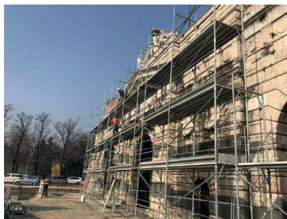
Restauro dei paramenti esterni della Porta Nuova
