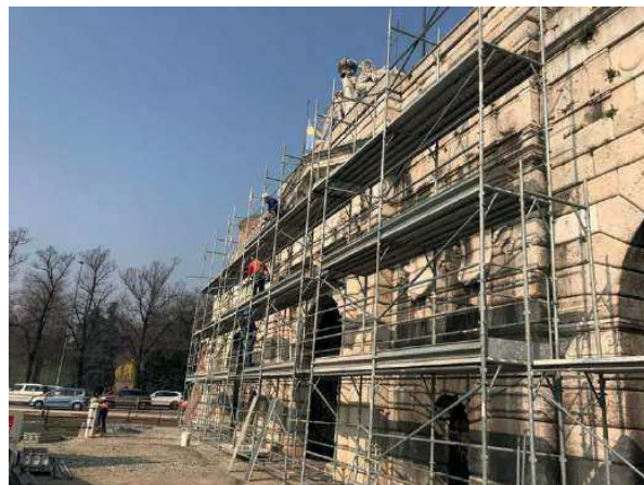
Restauro dei paramenti esterni della Porta Nuova
